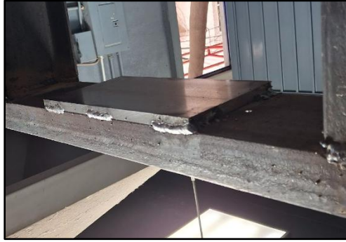
Figura 61. Posición de la placa de apoyo secundaria [Imagen propia].
