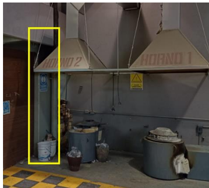
Figura 42.- Columna de concreto existente en el taller de fundición.
