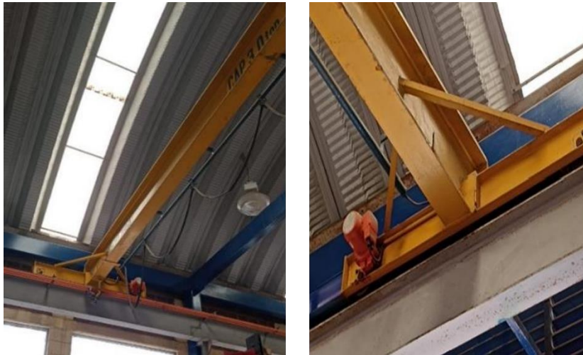
Figura 1.- Vista de ambos apoyos de grúa viajera en UAM-A.
