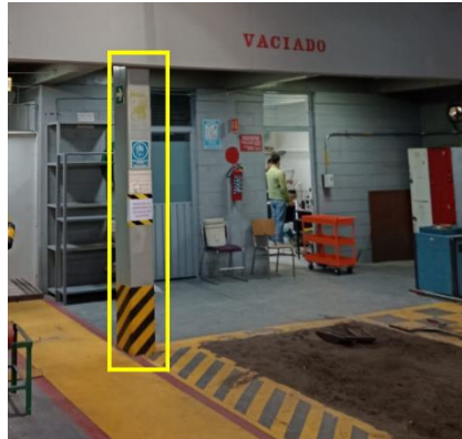
Figura 41.- Columna metálica existente en el taller de fundición.
