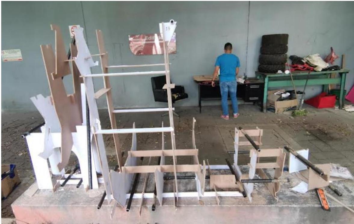
Figura IV.20 Montaje final de bastidor
