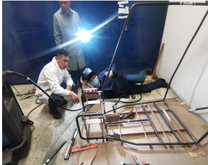
Figura IV.31 Colocación de nariz, remolque y RHO
