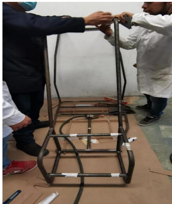
Figura IV.32 Colocación de travesaños
