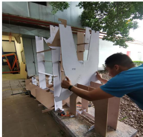
Figura IV.19 Montaje de piezas de bastidor
