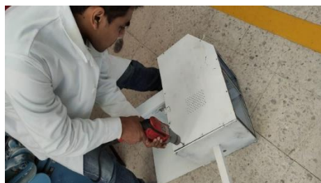
Figura 34.- Se quitan los remaches para desmontar los paneles del respirador.
