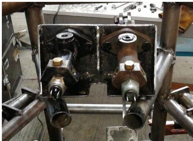
Figura 32. Montaje de cilindros a soporte.
