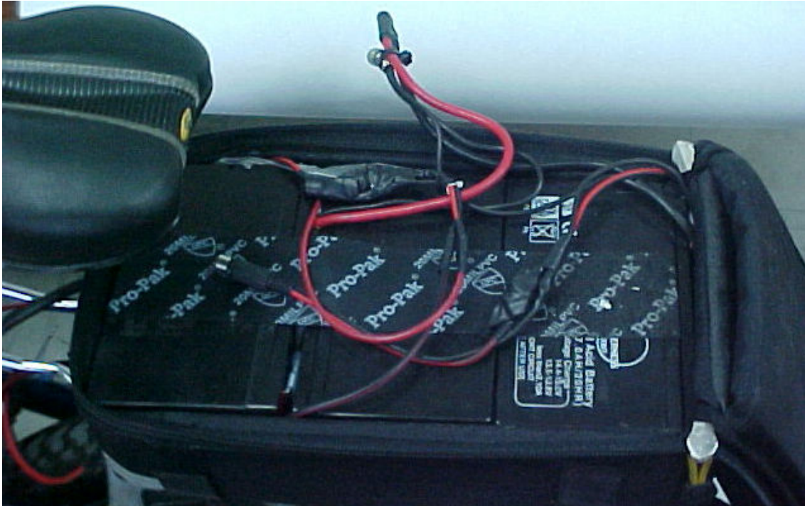
Figura 37 Vista superior del contenedor de baterías
